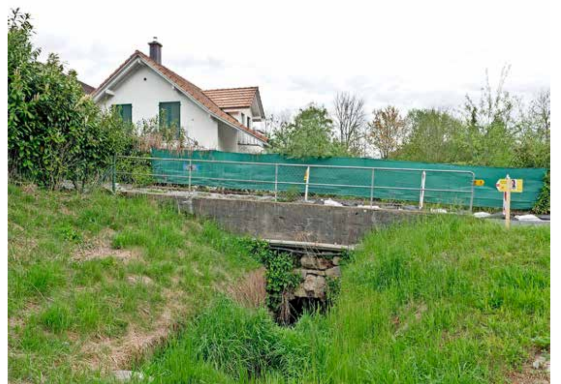
LKWs können nicht mehr hier über den Sensenbrückenbach fahren.
